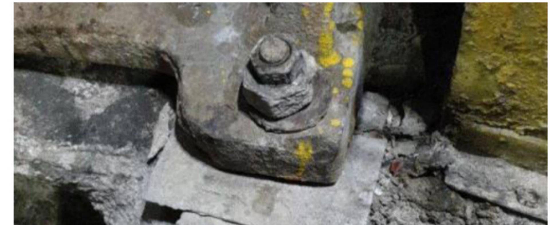
Достигнута дальность связи 500м. При пробном включении сразу выявлена повышенная вибрация на насосе 8 ГРТ-8 №14, по причине отсутствия качественного крепления подушки насоса
